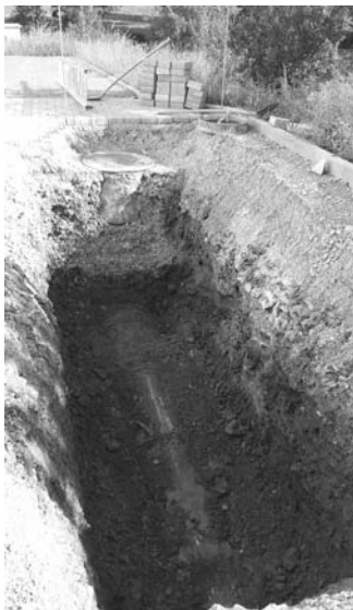
Kanalsanierung Oberes Tor mit Verschluss Schachtbauwerk
