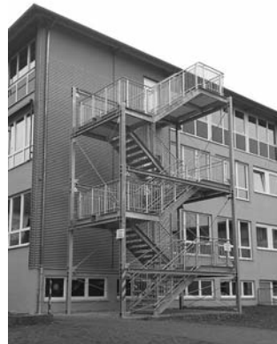
Neubau zweiter Rettungsweg Deutschorden-Schule mit Herstellung eines Fluchtturmes und Rauchschutzmaßnahmen
