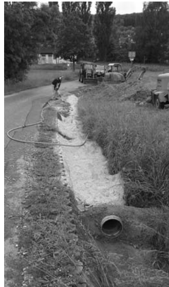
Straßensanierung Hettelsberger Weg
