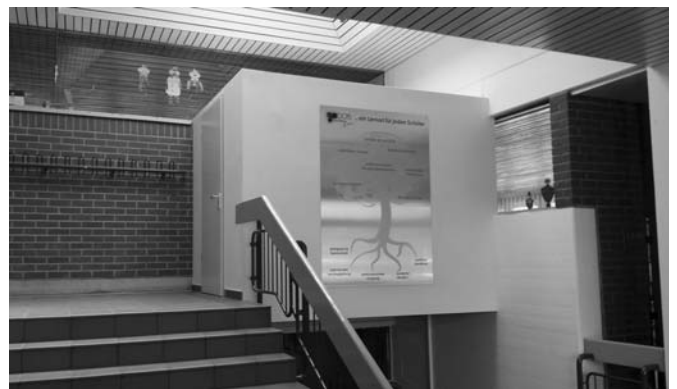
Einbau eines Abstell- und Lagerraumes in der Kapfenburgschule
