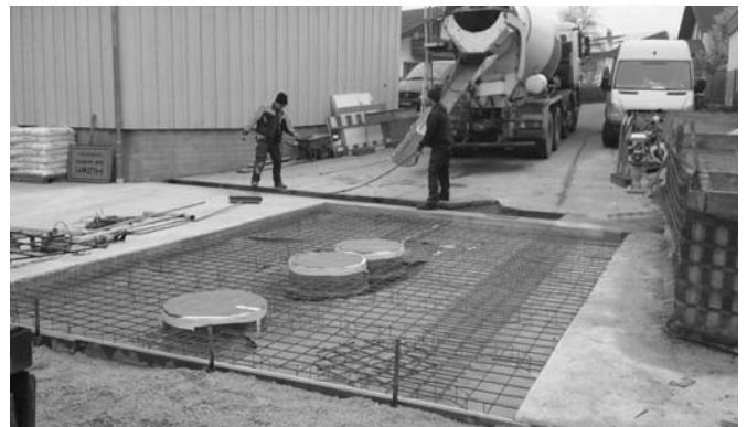
Neubau einer Waschplatte mit Leichtstoffabscheider für den Bauhof und die Feuerwehr
