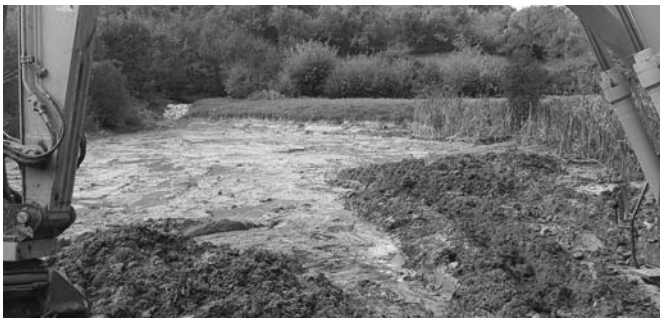
Entschlammung der Rückhaltebecken Feuerweiher und Leimental
